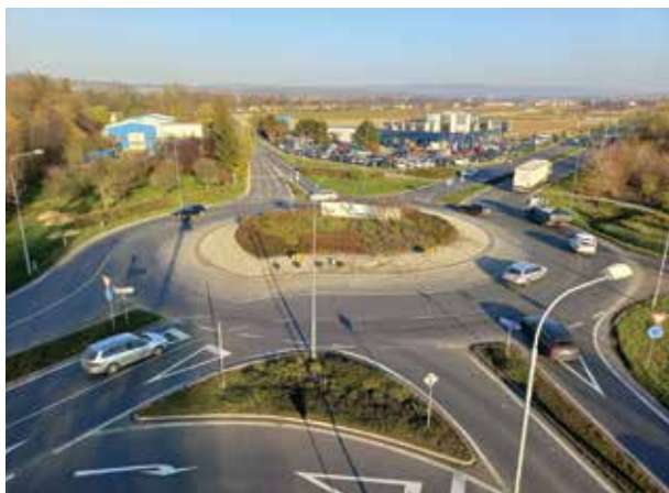
Obr. 2. Pohled na TOK v Olomouci v době průzkumu z vysokozdvíže plošiny
