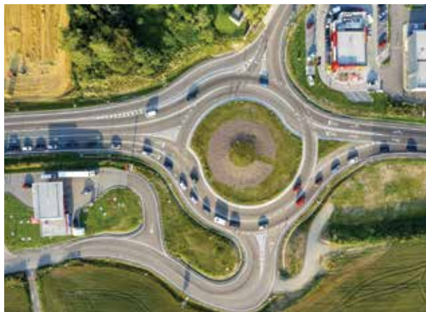
Obr. 1. TOK Červené vršky na silnici I/3 v Benešově (zdroj: [SUDOP PRAHA a.s.])
