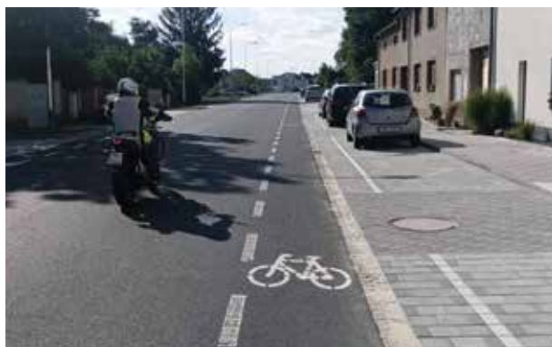
Obraz 1: ul. Olomoucká, Horka nad Moravou před a po rekonstrukci
