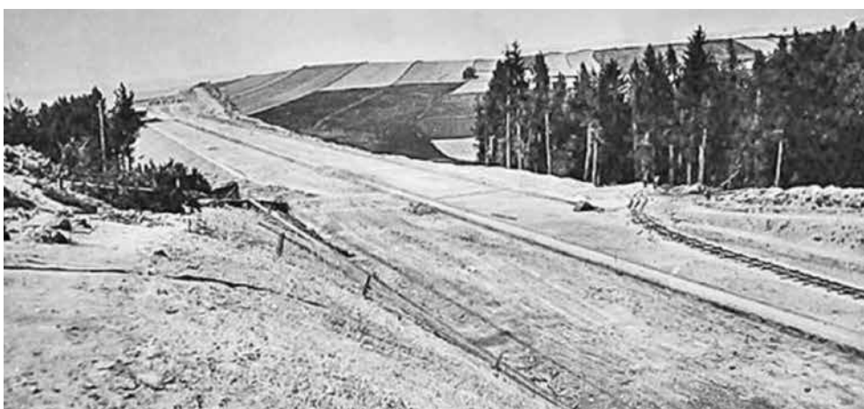
Dálniční těleso připravené k betonáži vozovek (1941)
