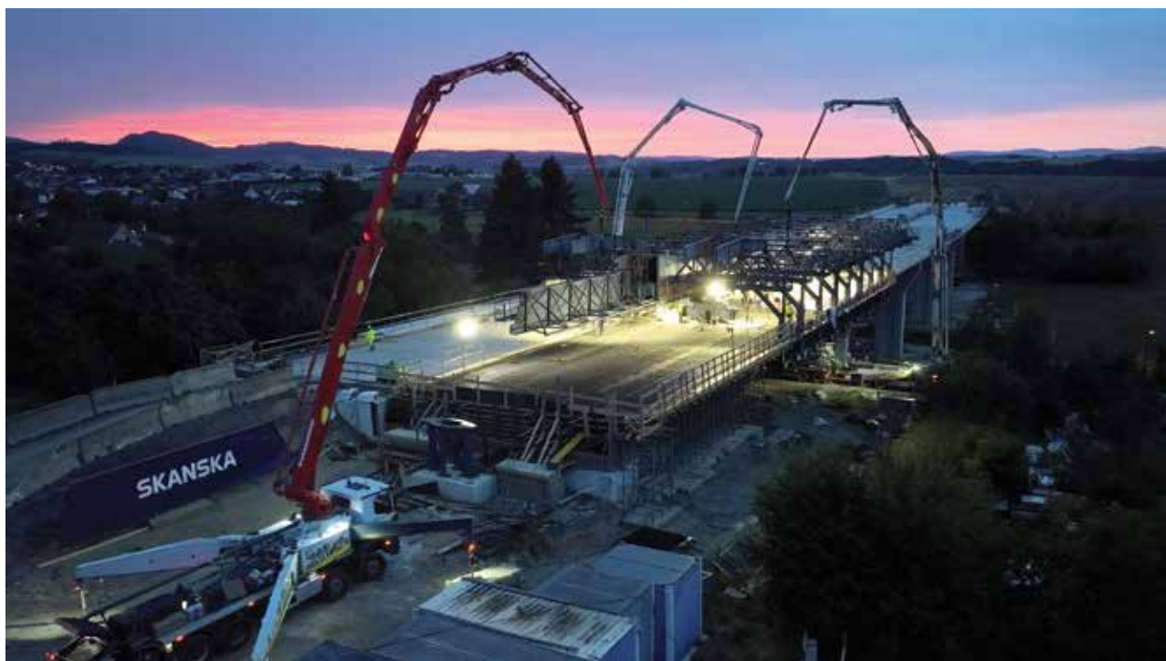
Obr. 5: Betonáž konstrukce
