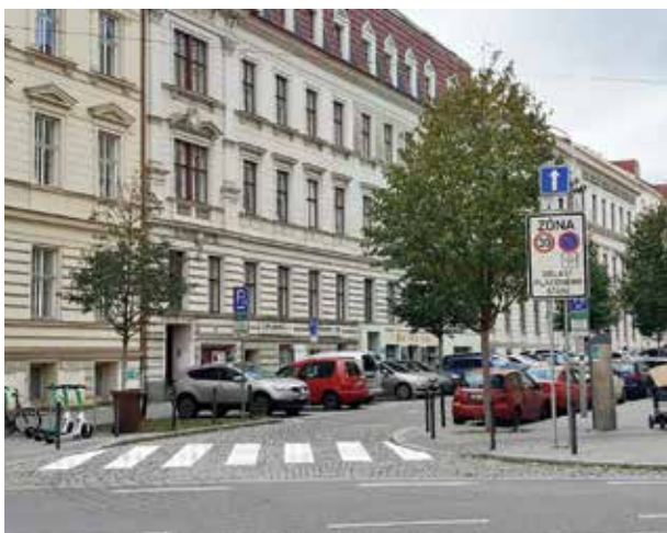
Obr. 2: Příklad vjezdu do zóny 30 pomocí změny povrchu vozovky s integrovaným přechodem, zdroj: [1]
