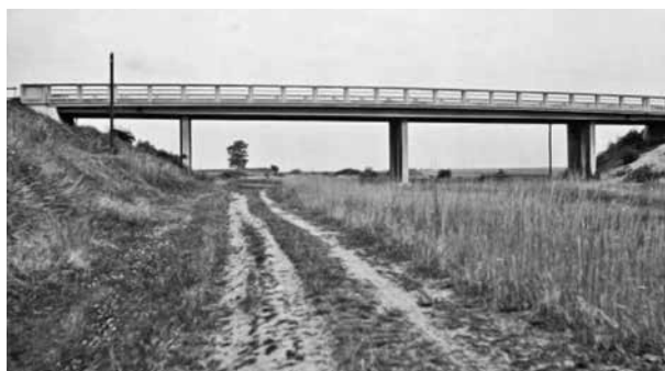
Typický most přes dálnici (1965)
