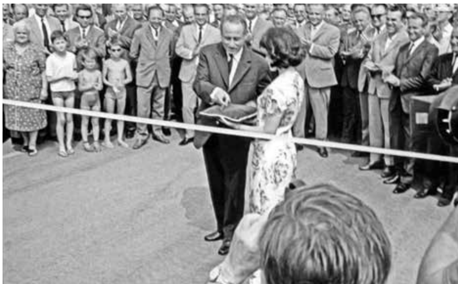
Slavnostní zahájení provozu na úseku Praha–Mirošovice 12. 7. 1971
