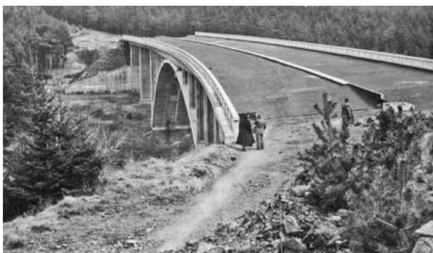
Most přes údolí Želivky (1956)
