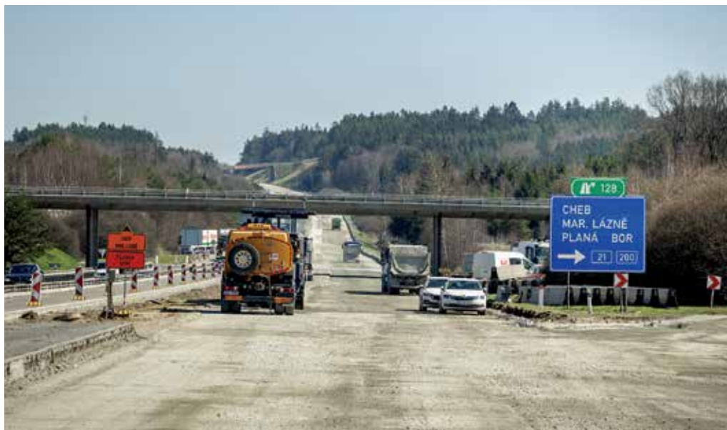
Obr. 2: D5 Oprava CB vozovky 129,9 - 122,59
