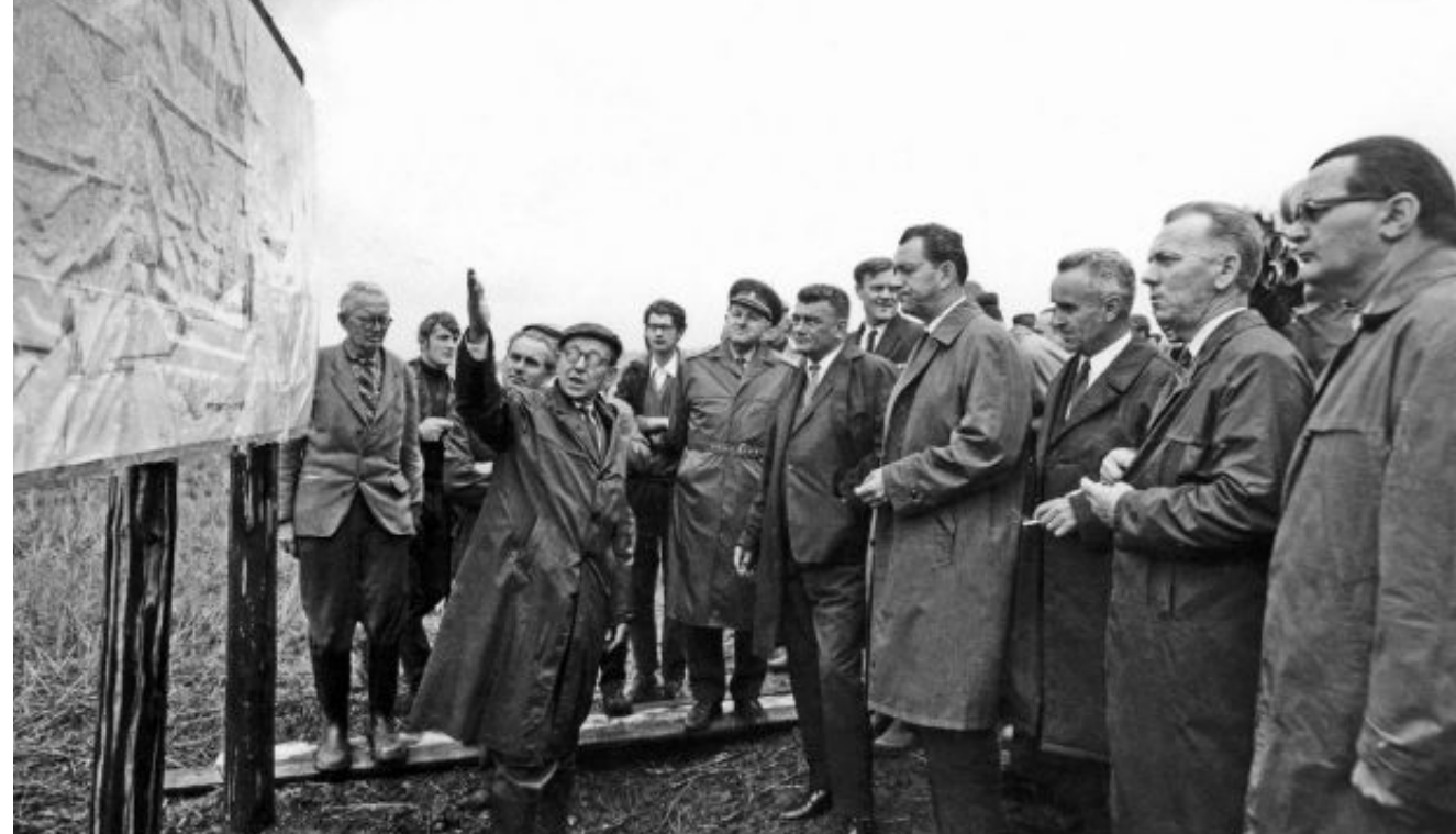
Znovuzahájení stavby dálnice 8. září 1967 u Spořilova.
