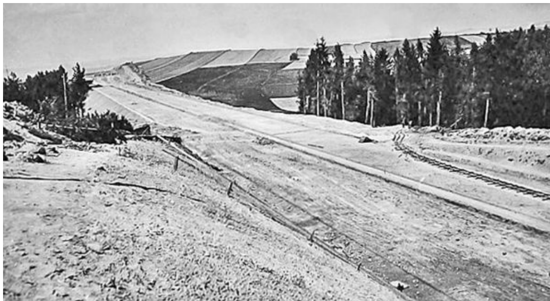
Dálniční těleso připravené k betonáži vozovek (1941)
