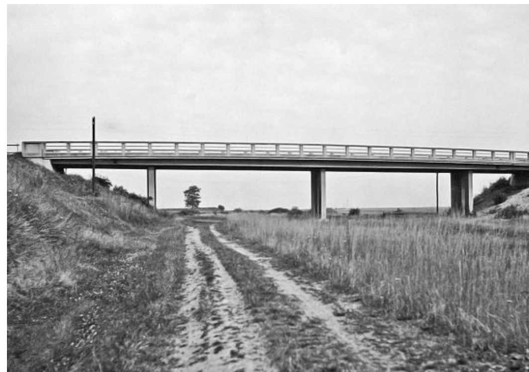
Typický most přes dálnici (1965).
