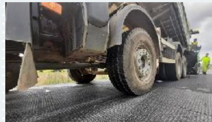
Pokládka ACO 11+ na mříž
