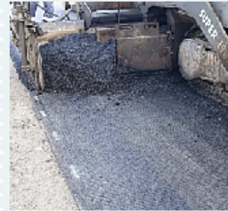
Pokládka ACO 11+ na mříž
