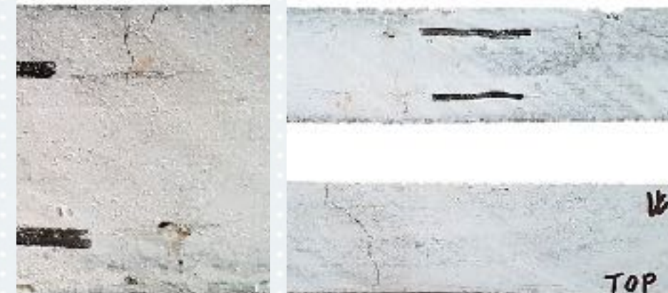
Zkušební trávce po zkoušce odolnosti vůči únavě
