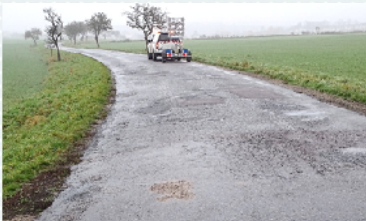
Původní stav vozovky (2020)
