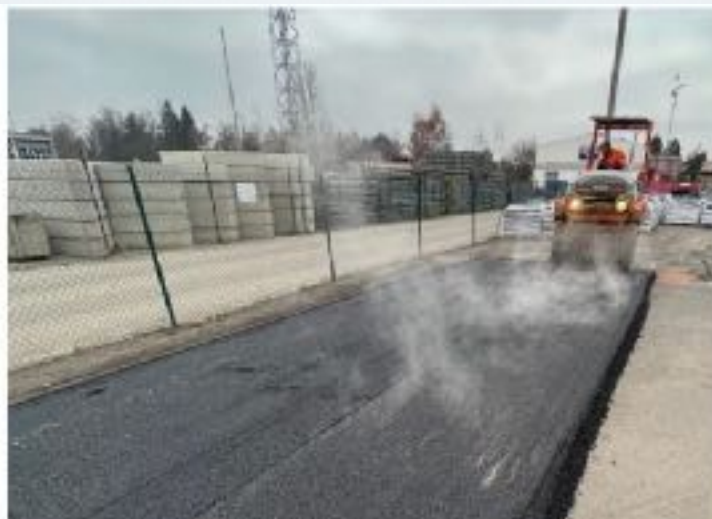
Pokládka tenké obrusné vrstvy na kompozit
