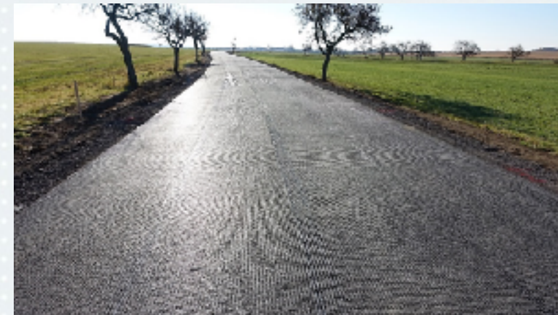
Celoplošná instalace mříže 1 (2021)
