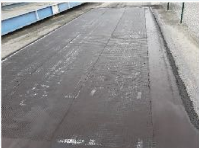
Instalace výztužného kompozitu
