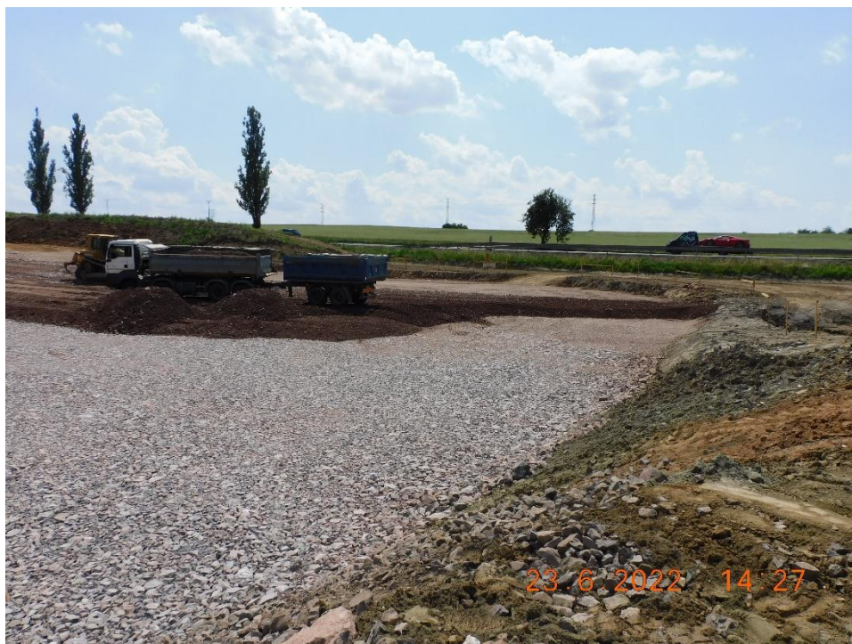
Obr. 2 Písecká přechodová oblast mostu SO 201 úsek Milín – Lety (sanace lomovým kamenivem 0/250 mm)
