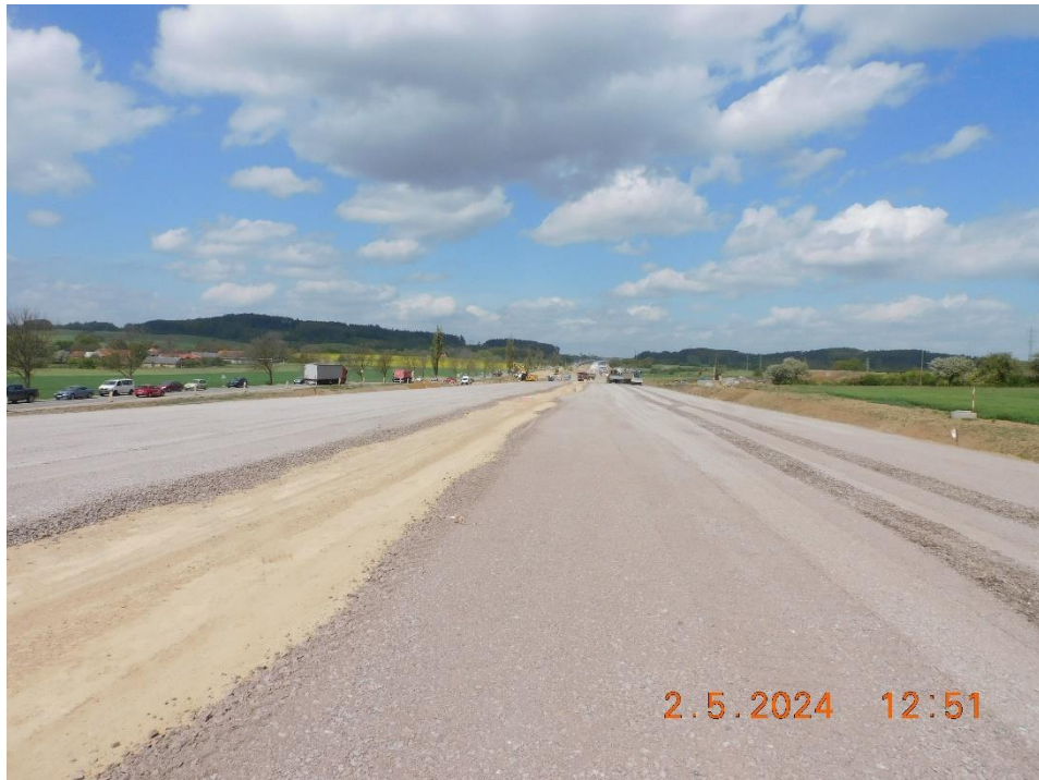
Obr. 8 Úsek Hlavní trasa Milín – Lety km 53,300 ochranná vrstva ze štěrkodrti 0/32 mm na upravené zemní pláni násypu
