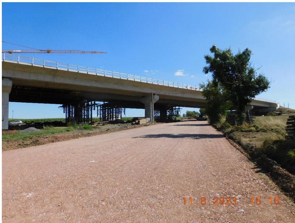
Obr. 7 Úsek Milín – Lety SO 137 Přeložka II/604 zemní pláň
