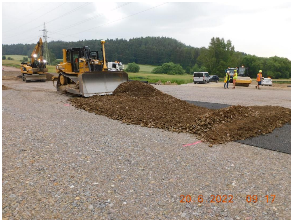
Obr. 3 Hlavní trasa Háje – Mílín km 50,500 zhutňovací zkouška pro vyztužený násyp N13 (roznášecí deska)
