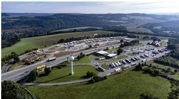
Obr. 1 Odpočívka D1 Střechov, levá strana (rozšířeno v 09/2022)
