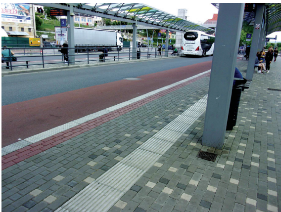
Obr. 10 Nástupní hrana autobusů, detail
