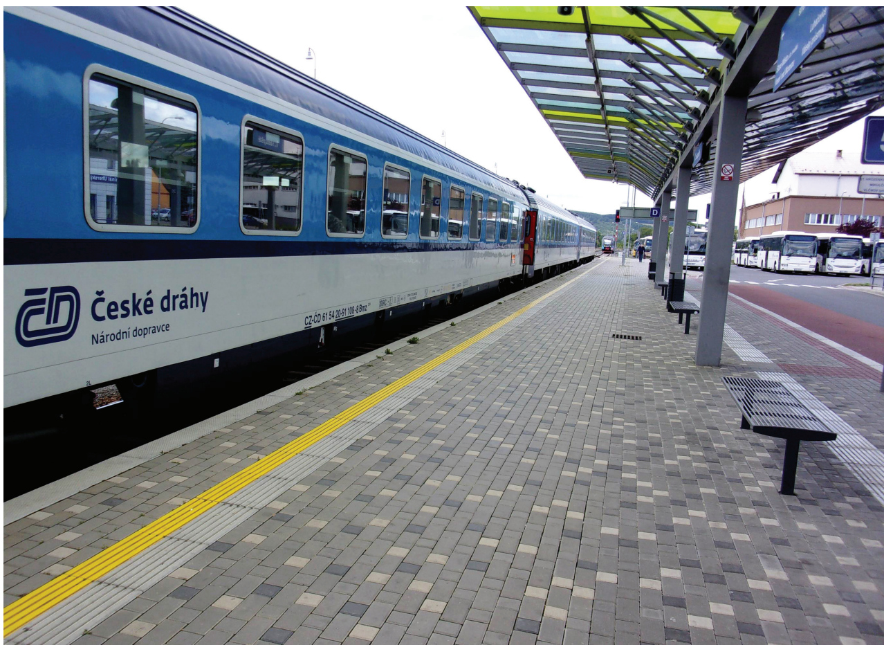
Obr. 5 Celkový pohled na obě nástupní hrany a hmatové úpravy v jejich blízkosti
