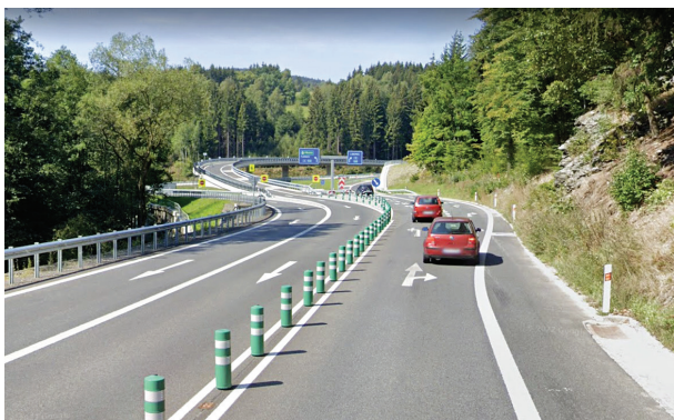
Obr. 2 Příklad opatření proti najetí do protisměrného jízdního pásu (I/65 MÚK Rádelský mlýn)
