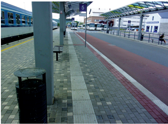
Obr. 8 Nástupní hrana autobusů, celkový pohled
