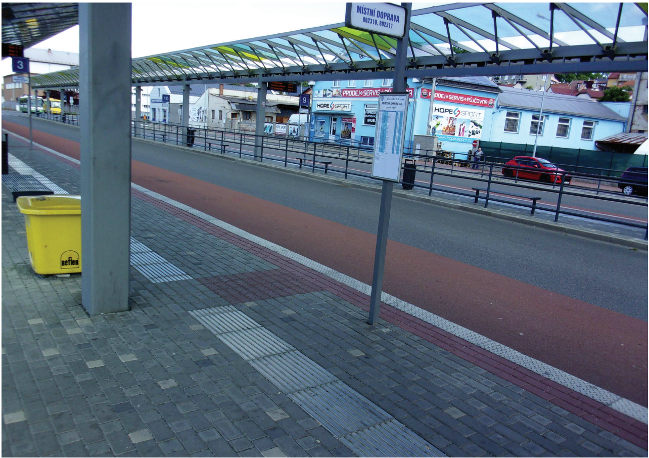
Obr. 7 Detail nástupní hrany autobusů v místě označnicku zastávky
