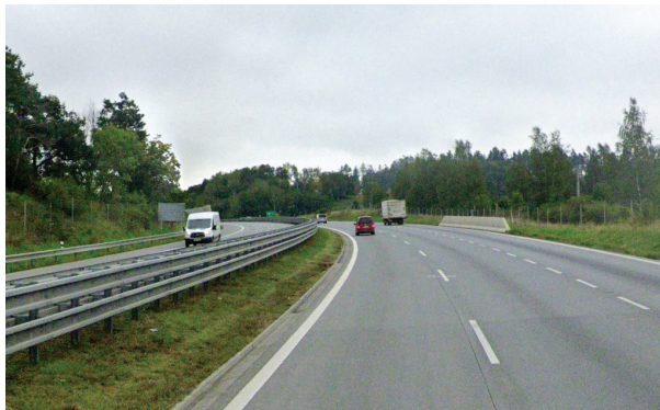
Obr. 1 Podmínky rozhledu v levotočivém směrovém oblouku na dálnici lze zlepšit odsunutím svodidla k okraji středního dělicího pásu, ale pouze pokud v SDP není žádná překážka – např. mostní pilíř, sloup portálu apod. (D1 u Ostředku)
