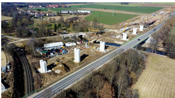
Obr. 3 Estakáda přes řeku Skalici
