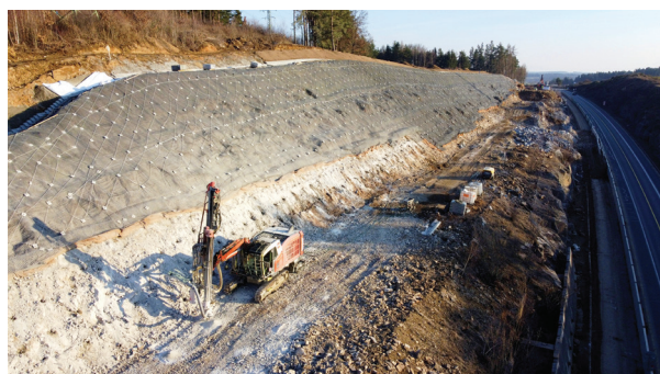
Obr. 5 Odstřely skalního masivu u Milína
