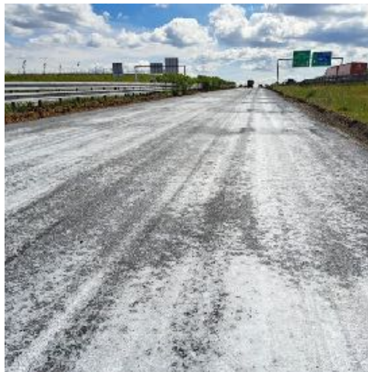
Aplikace vápenného mléka na SC
