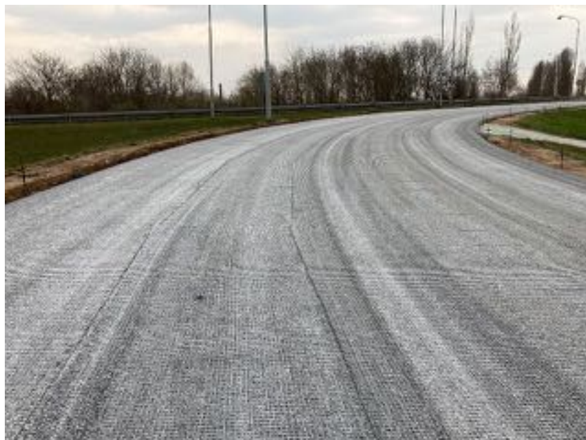
Aplikace mléka na geokompozit a spojovací postřík
