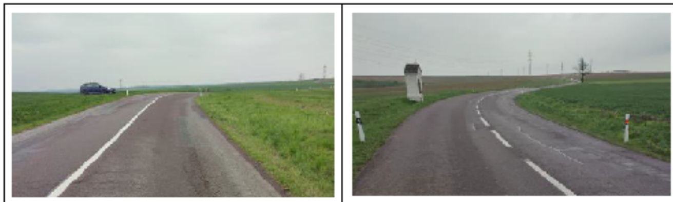
Obrázek 5: Místa chybějícího dopravního zařízení (vlevo oblouk 2 – jízda ve směru na levěšovic, zprava oblouk 3 – jízda směrem na Znojmo).
