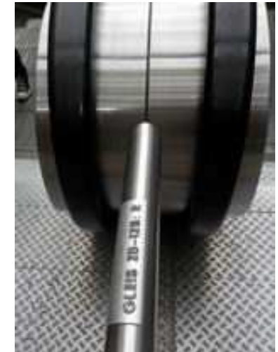
eskalátor bez akustické signalizace pro nevidomé, Německo „náhrada“ hmatnou informací na madle !!!
