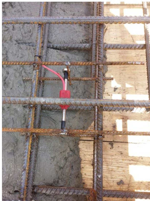
Obr. 16: Osazený tenzometr č. 1 – spodní deska betonáž komory.
