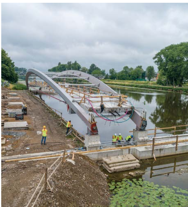
Obr. 4: Přesun konstrukčního dílu nad vodní tok.
