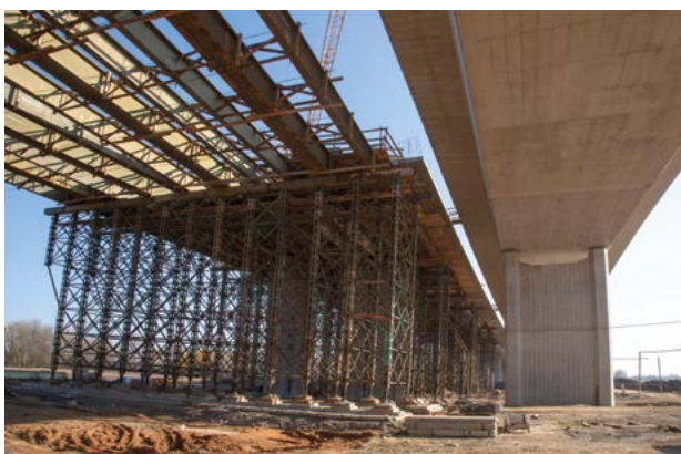
Obr. 9: Pevná skruž L18-L23 – I nosníky.
