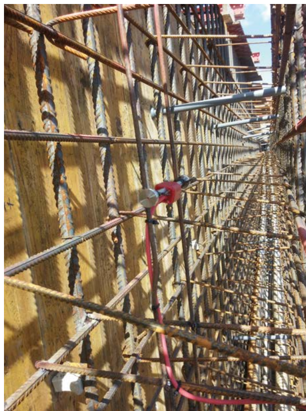
Obr. 15: Osazený tenzometr č. 4 – stěna.
