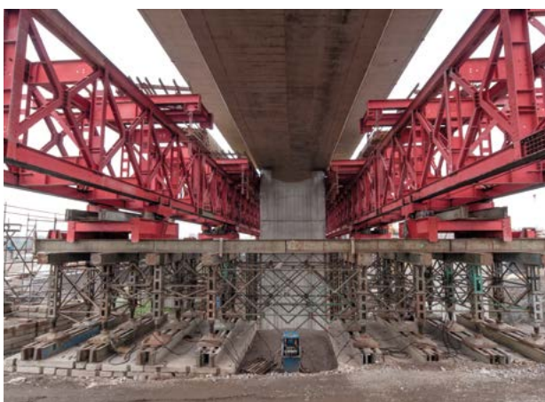
Obr. 8: Přesuvná skruž v poloze odbedněno.
