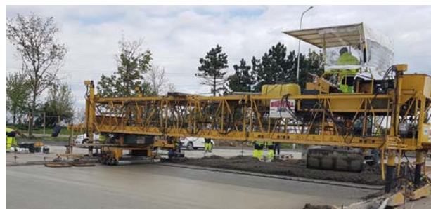
Obr. 5: Pokládka whitetoppingu odpočívka D2 Ldná.
