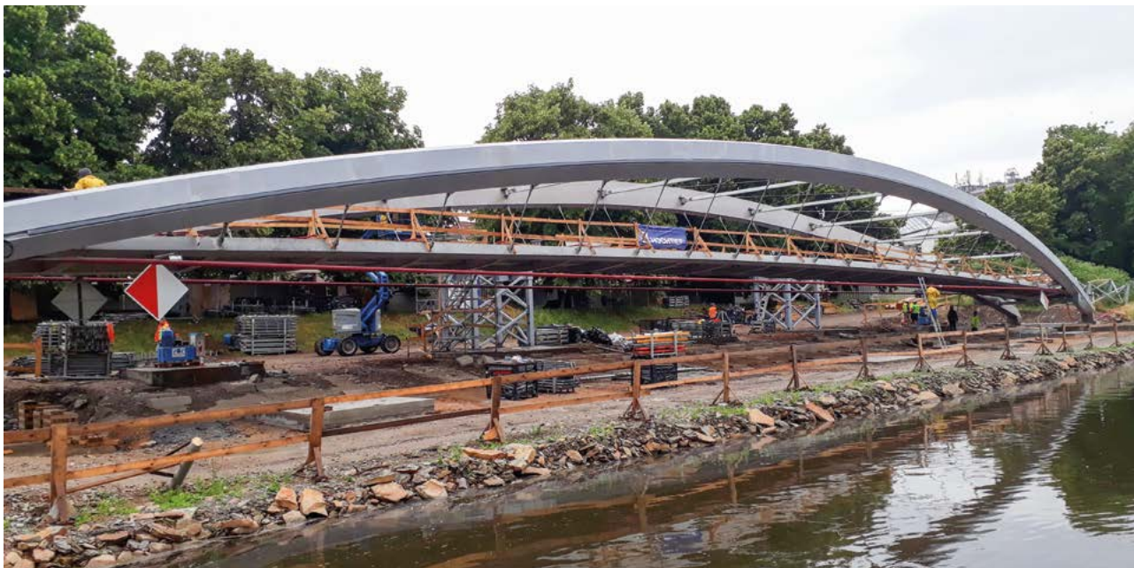
Obr. 3: Zkompletovaný oblouk s napnutým táhlem.
