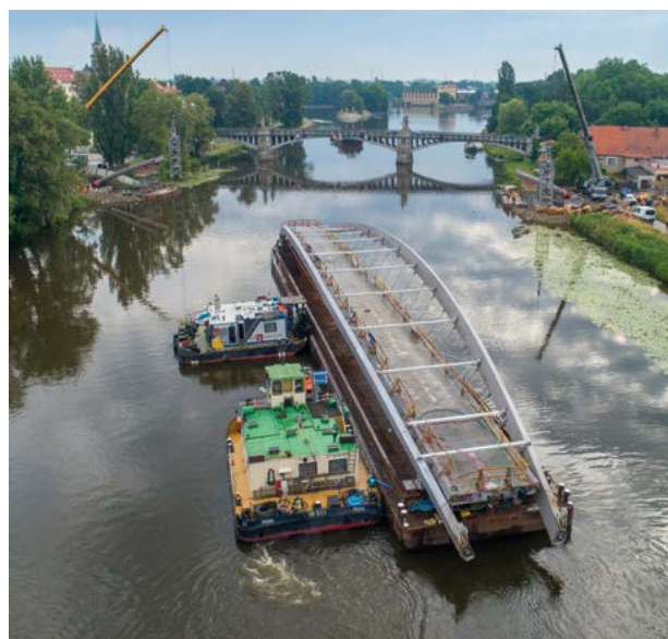
Obr. 6: Transport konstrukce 300 m proti proudu.
