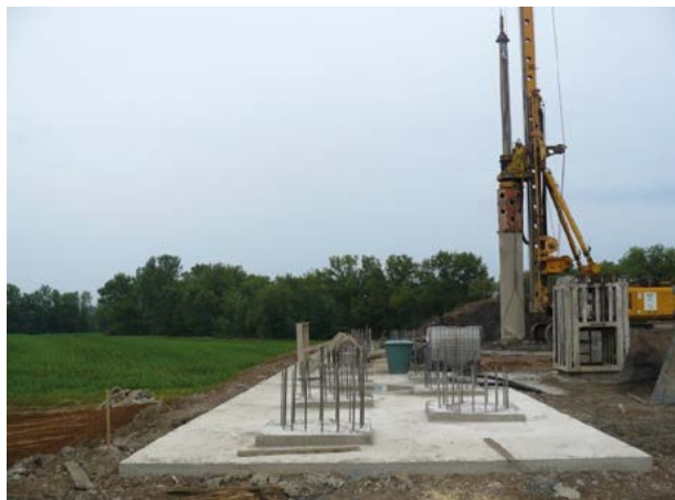
Obr. 2: Vrtání velko-průměrových pilot.
