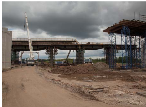
Obr. 10: Pevná skruž L41 – L49A – ŽBM nosníky.
