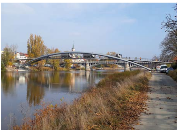
Obr. 9: Hotová lávka, zatěžovací zkouška.
