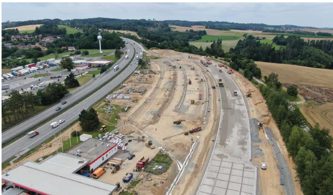
Odpočívka D1 Střechov L 07/2022.
