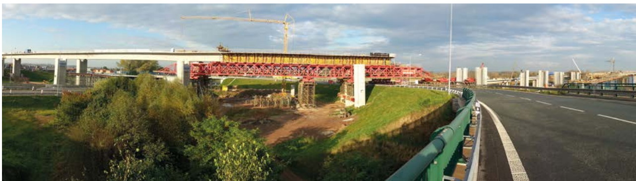
Obr. 6: Fotografie z realizace mostu.
