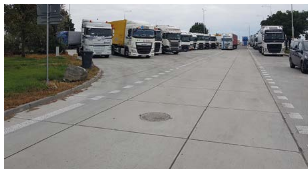
Obr. 6: Hotová vrstva whitetoppingu odpočívka D2 Ldná.
