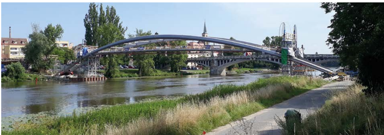
Obr. 8: Kompletní oblouk, zatížení ještě přenášeno dočasnými věžemi.
