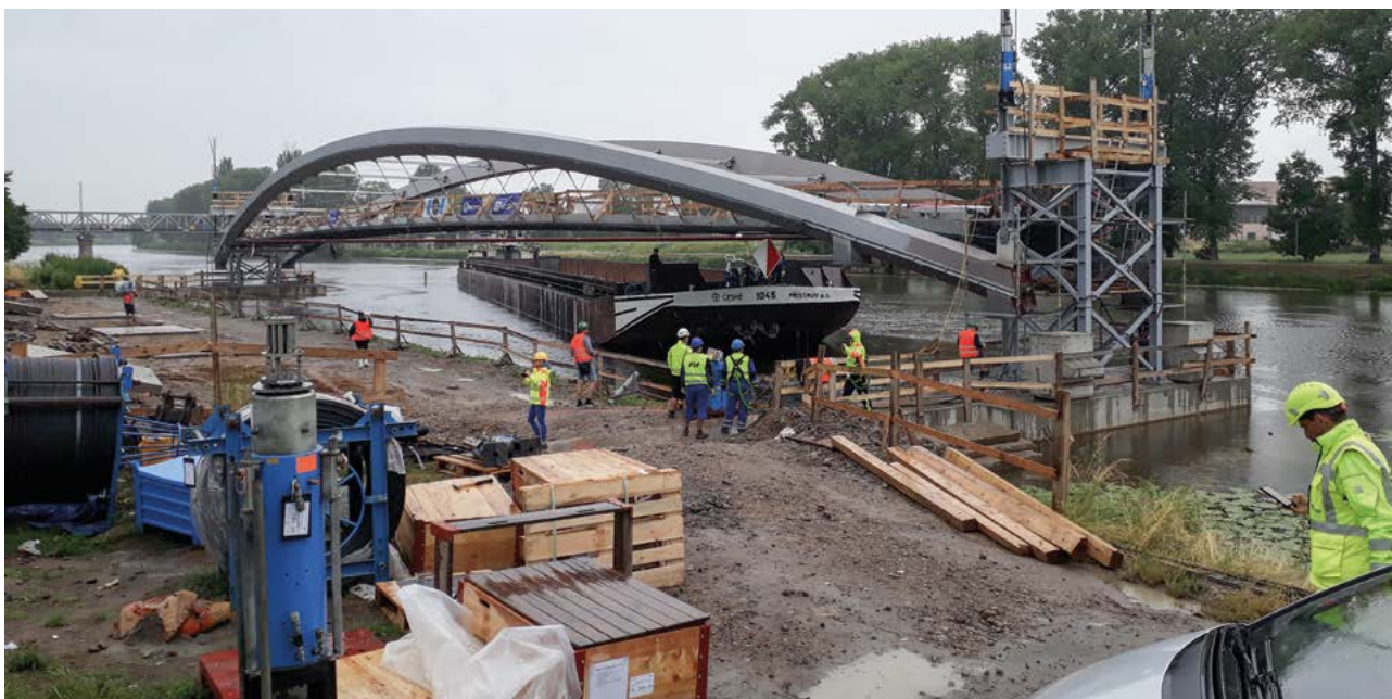
Obr. 5: Uložení oblouku s táhlem na plavidlo.
