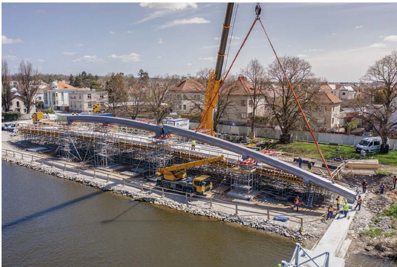
Obr. 2: Mostovka vybetonovaná na skruži a montáž oblouku.
