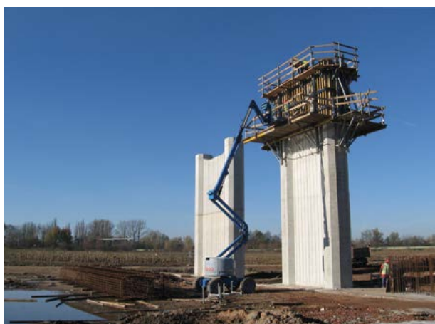
Obr. 3: Výstavba pilířů pomocí systémového bednění.
