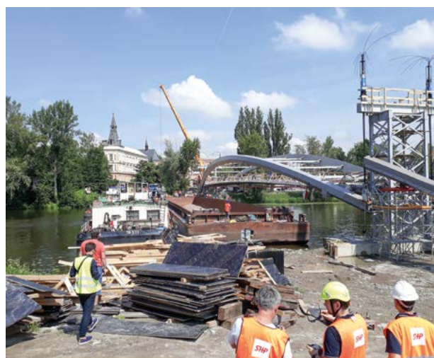
Obr. 6: Transport konstrukce 300 m proti proudu.
