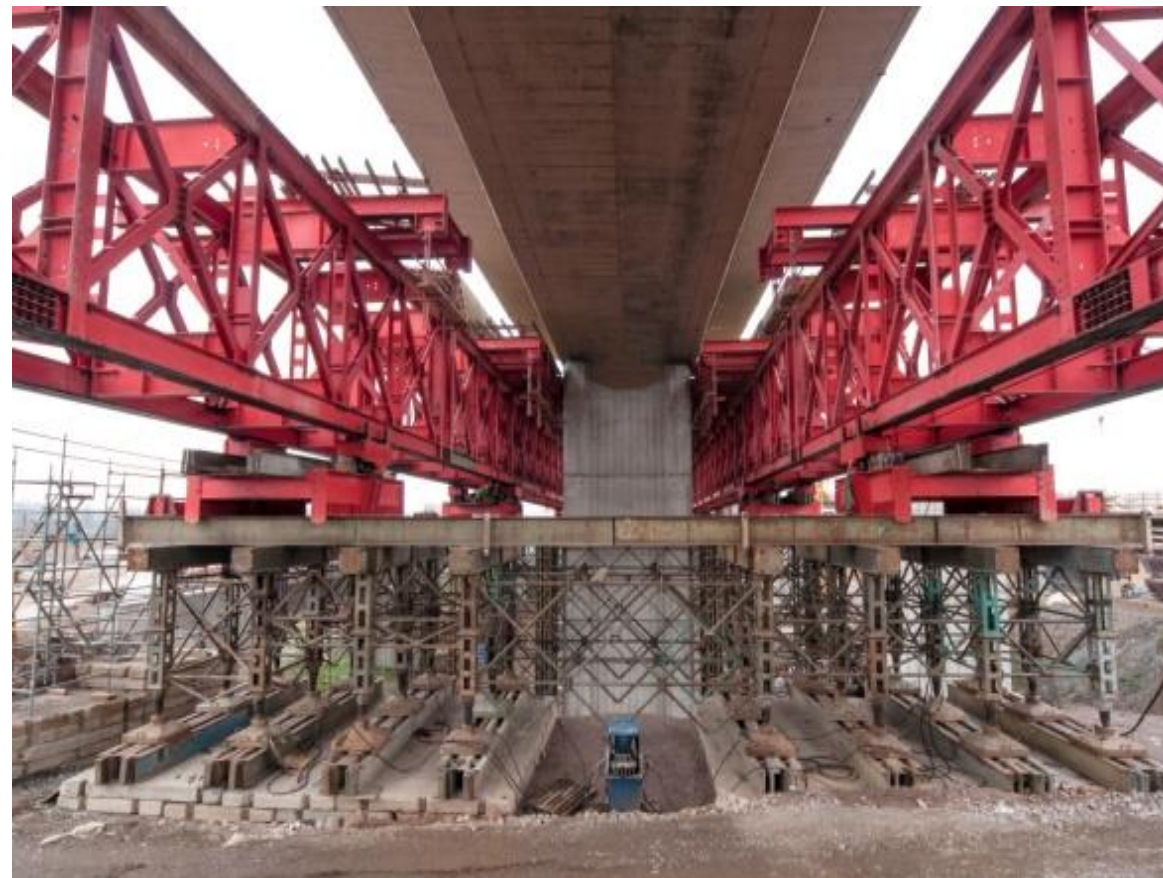
Přesuvná skruž v poloze odbedněno
