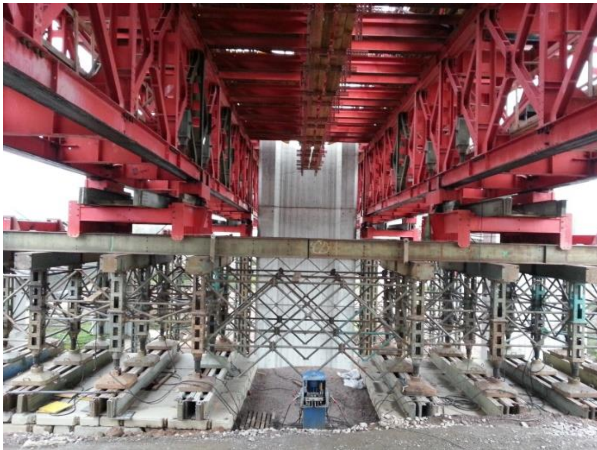
Přesuvná skruž v poloze zabeďněno
