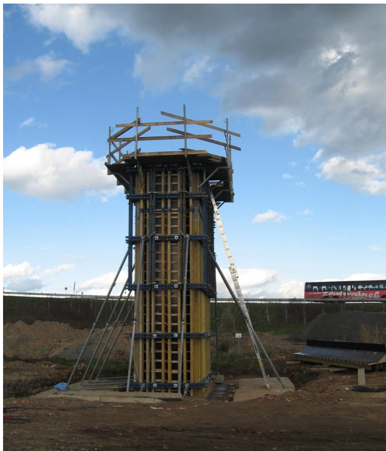
Systémové bednění DOKA Základní forma 11,9 m.
